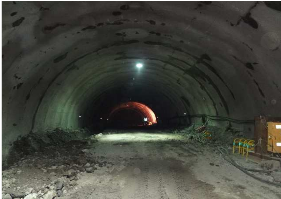
서면1터널 종점부 내부 전경
