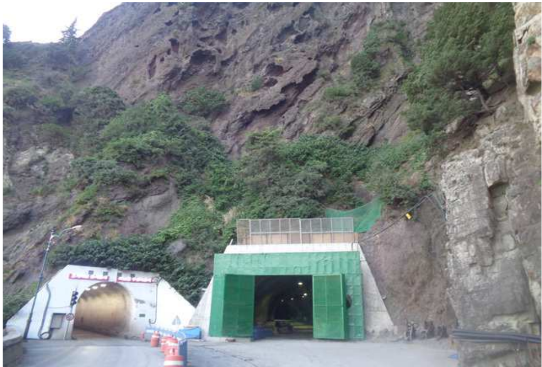
서면1터널 종점부 갱구 전경
