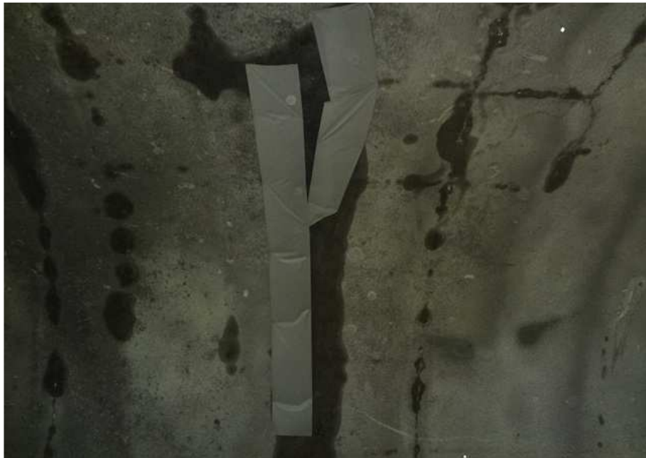
STA 0+395 ~ 0+519 방수공 현황
