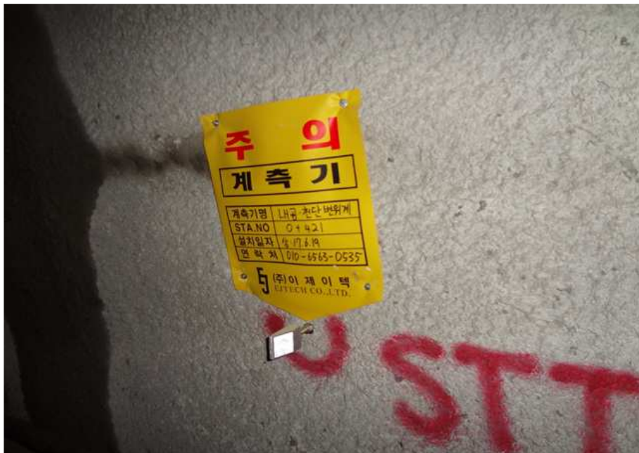
STA 0+395 ~ 0+519 터널 계측 현황
