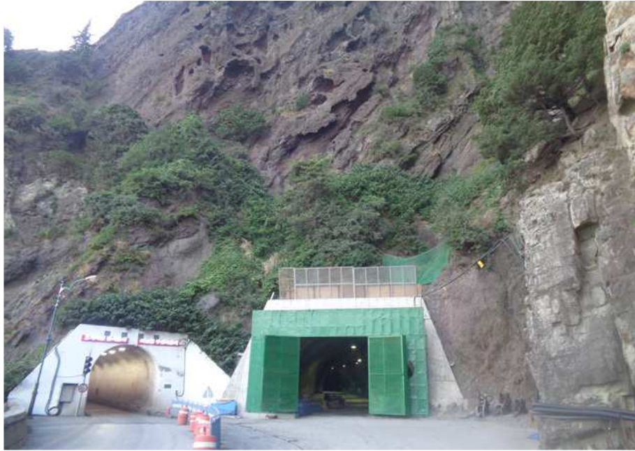
서면1터널 종점부 갱구 전경
