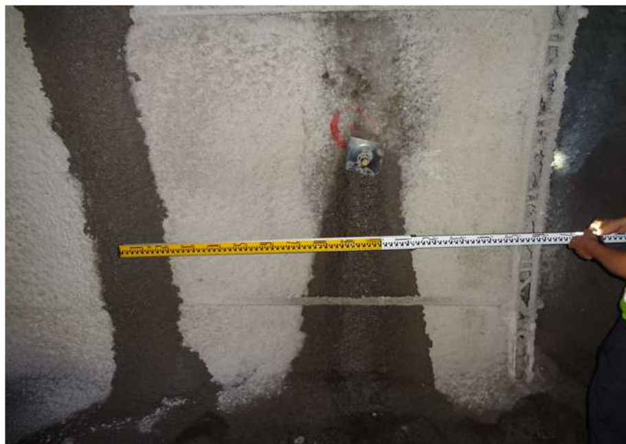
STA 0+395 ~ 0+519 터널 지보공 현황
