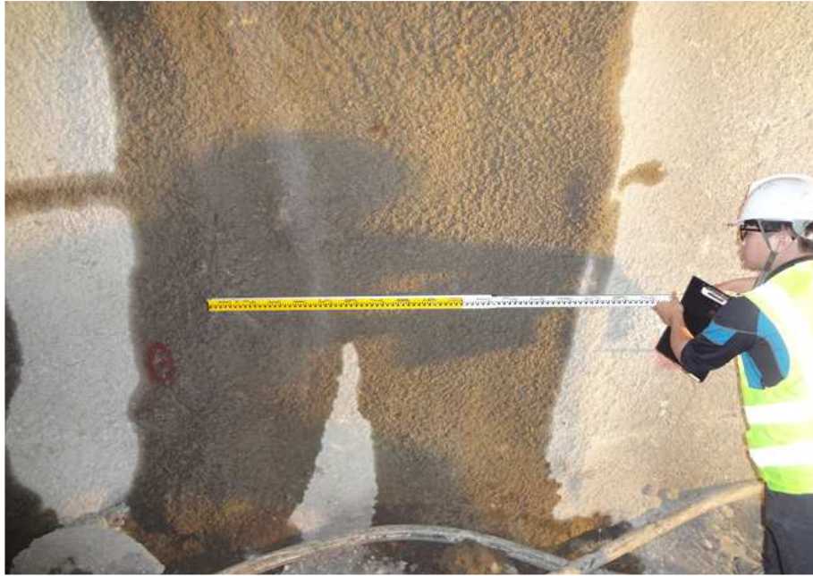
STA 0+395 ~ 0+519 터널 지보공 현황
