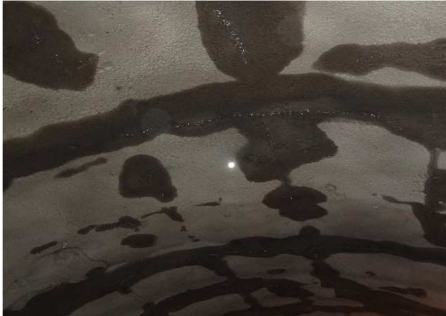
STA 0+395 ~ 0+519 터널 계측 현황
