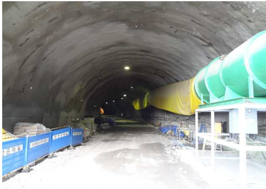
0+395 ~ 0+519 공사중 환기시설 현황
