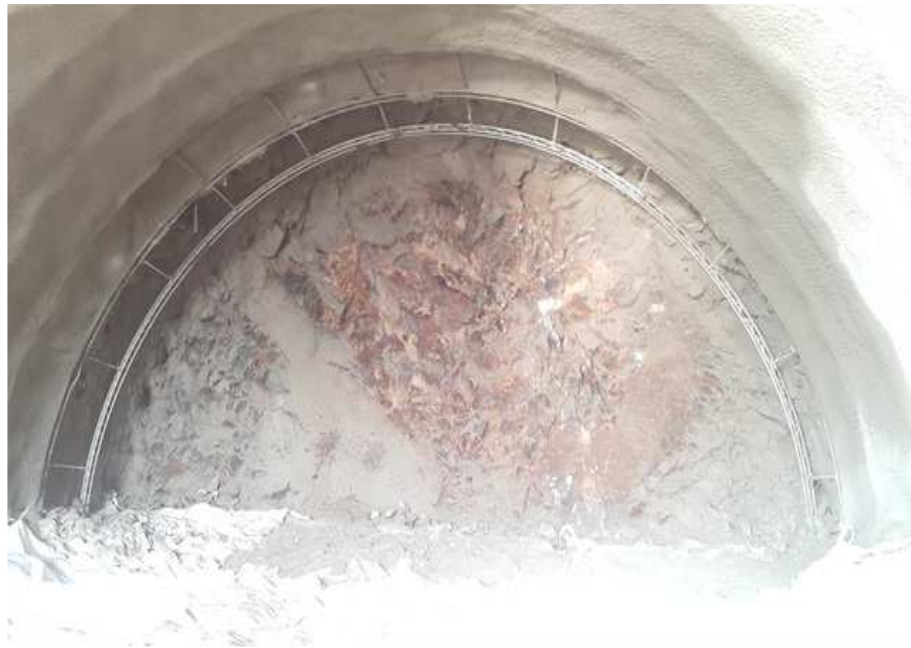
STA 0+395 ~ 0+519 터널 굴착 현황
