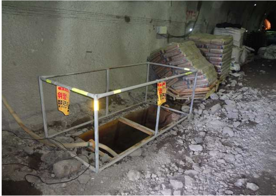
오·폐수 처리시설 전경
