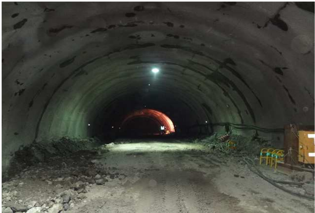
서면1터널 종점부 내부 전경
