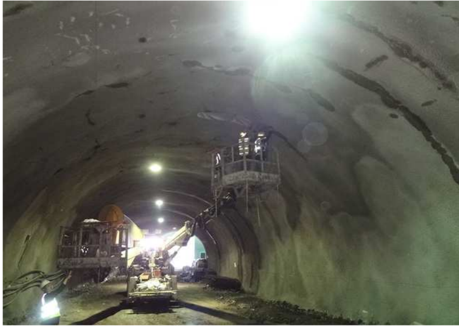
STA 0+395 ~ 0+519 방수공 현황
